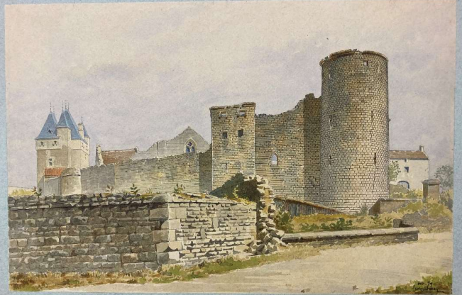
Château de BERRYE (Vienne) Vue Extérieure Côté Sud
